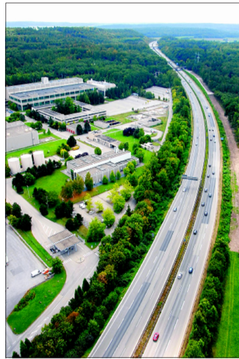
Auf diesem Areal soll das Kraftwerk entstehen. Die hinteren Gebäude sind mittlerweile abgerissen KRZ-Foto: Bischoff/Archiv
