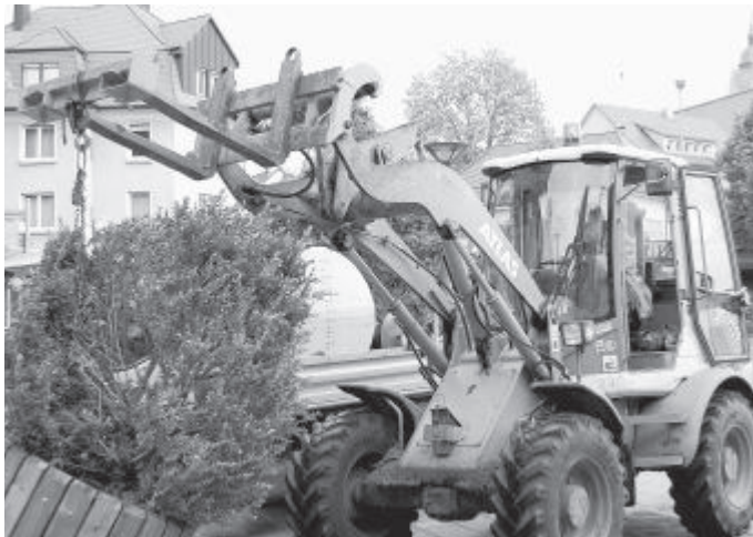
Die Stadtgärtnerei im Einsatz
